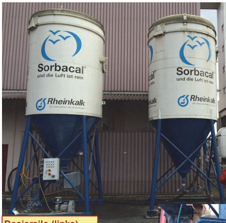
Dosiersilo (links) Vorratssilo (rechts)
