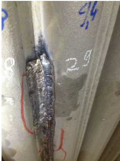
Abb. 2-7: Nachvernickelung Paneelstöße 2014
