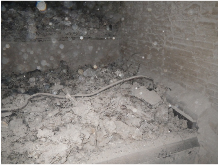
Abb. 2.5: Ausbrandrost
