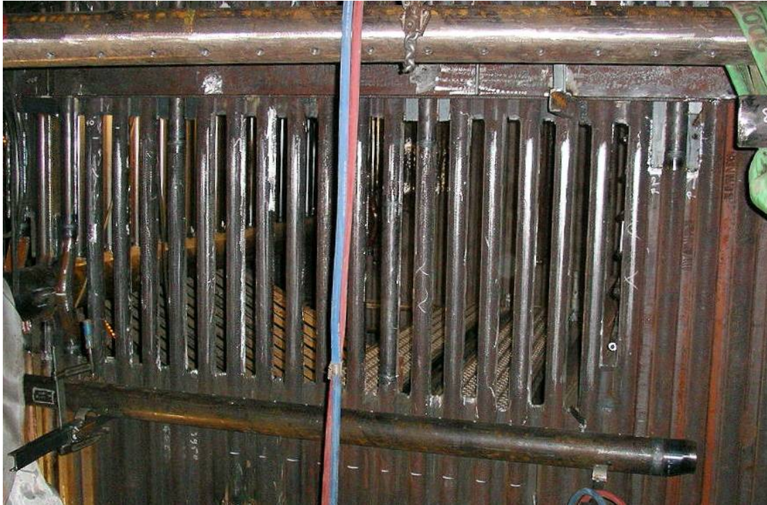
Abbildung 21: Vorbereitung Membranwand für SSF Montage
