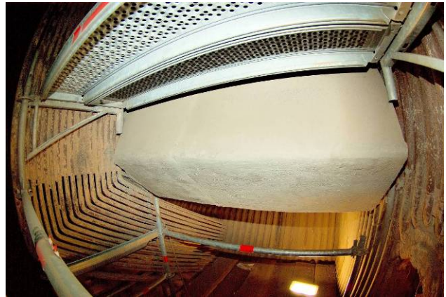
Abbildung 23: Sicherstellung Durchströmung an Überströmrohren Abbildung 24: Umlenkung 2./3. Zug „GKS-Nase“
