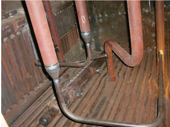
Abbildung 23: Sicherstellung Durchströmung an Überströmrohren Abbildung 24: Umlenkung 2./3. Zug „GKS-Nase“
