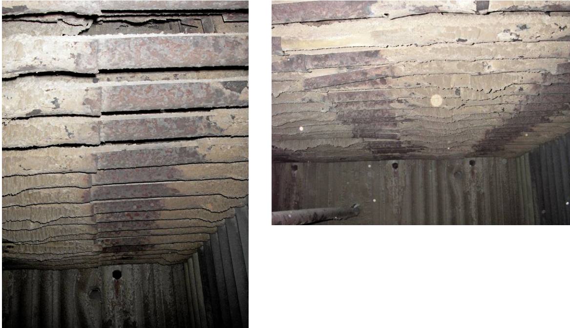
Abbildung 2: Reinigungswirkung Prototyp HWS an ÜH-Paket 4
