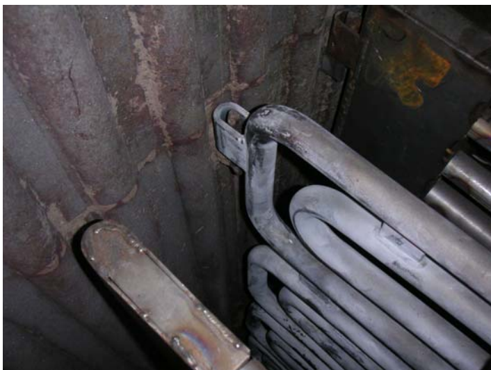
Metallische Schutzschicht bei Einbau. Standzeit bislang über 15.000 Std. ohne erkennbare Fehlstellen
