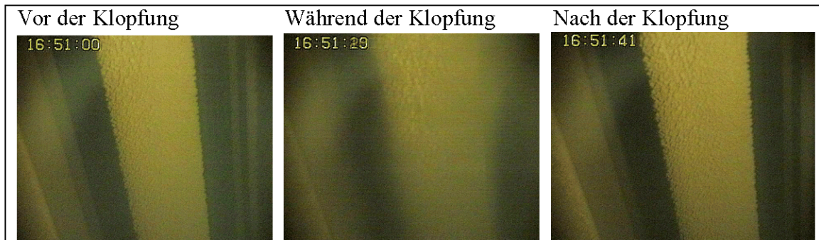
Abb. 17: Anströmseite eines Überhitzers
