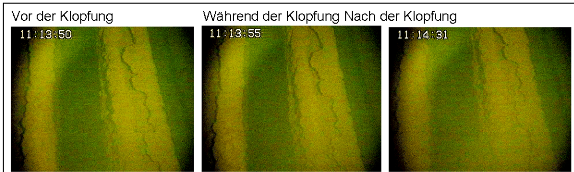
Abb. 20: Anströmseite eines Überhitzers (1. Bündel)
