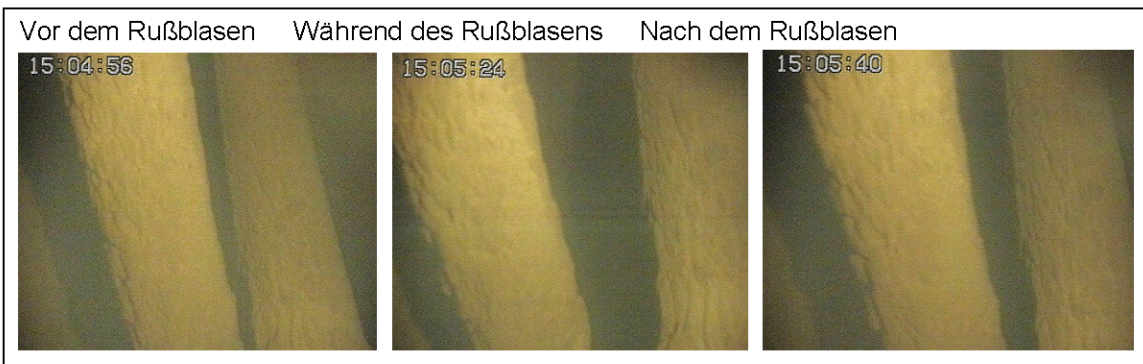
Abb. 8: Abströmseite eines Überhitzers (linkes Rohr) und Tragrohr (rechtes Rohr)
