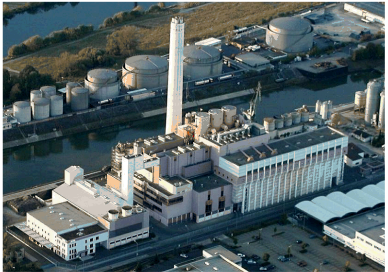
Abb. 1: GKS Gemeinschaftskraftwerk Schweinfurt
