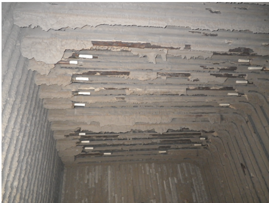
(a) Foto nach der Entnahme von Testrohren (b) Sicht zwischen die einzelnen Scheiben [8]
