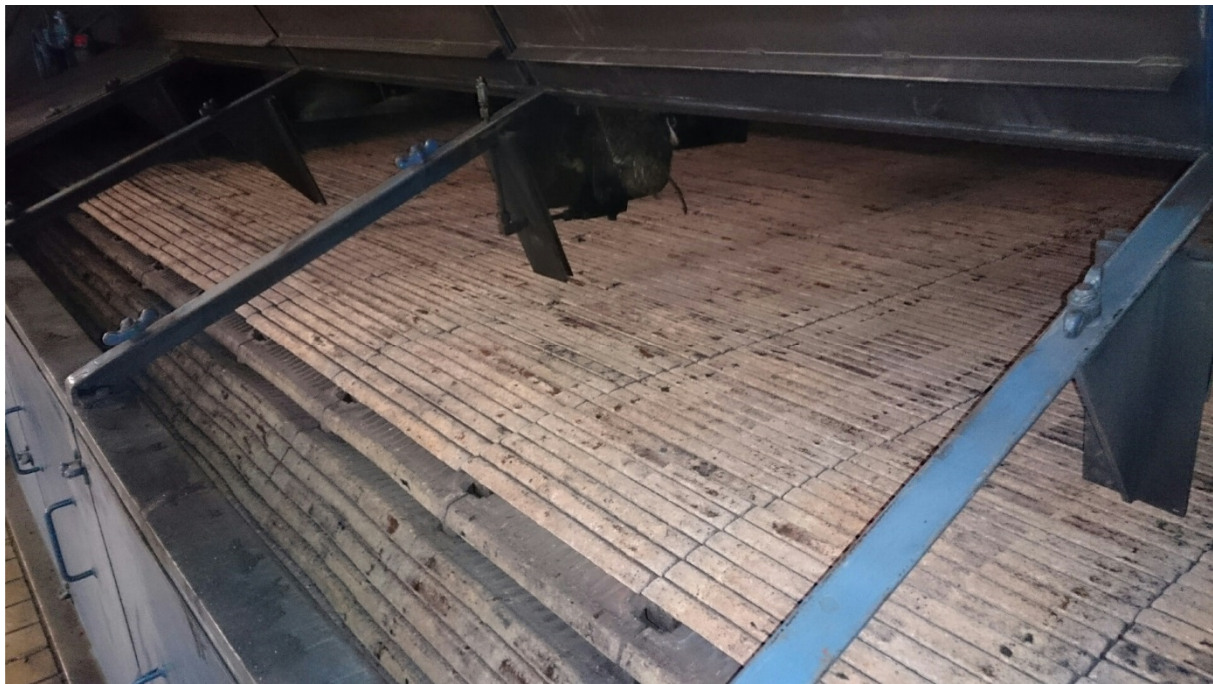
Abb. III-3: Wanderrost eines Kohlekessels
